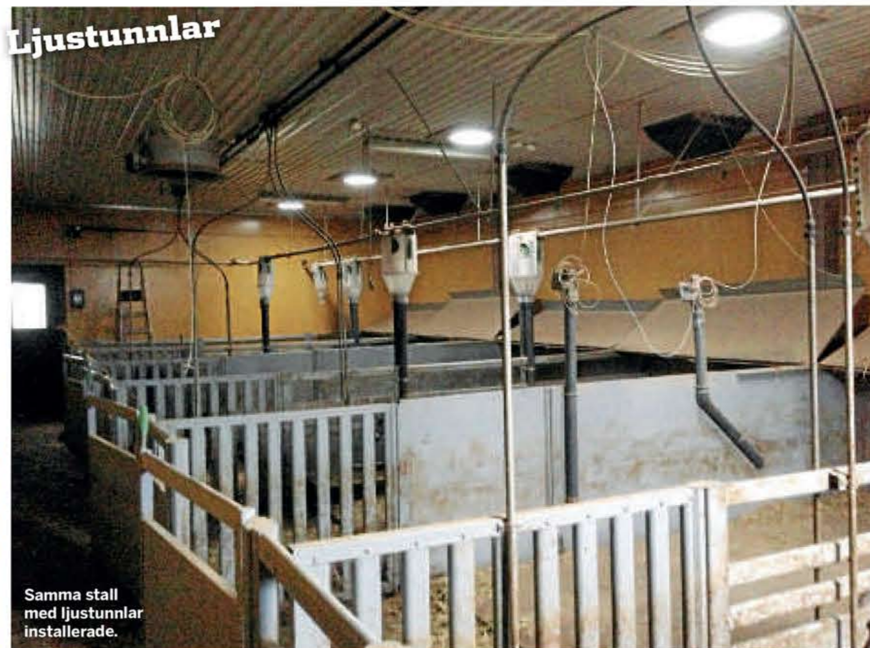
Solljuset överförs genom en högreflekterande tub och träffar ett prisma. Prismat sprider ljuset ut i rummet.
