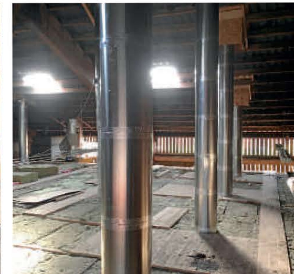
Solljuset överförs genom en högreflekterande tub och träffar ett prisma. Prismat sprider ljuset ut i rummet.
